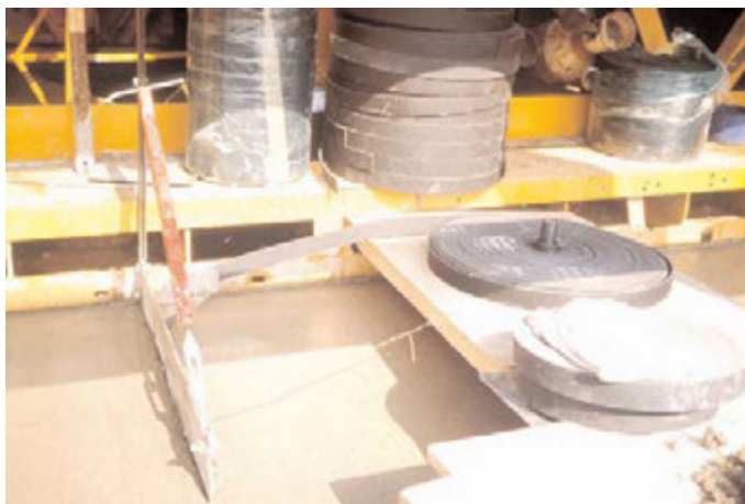
Figura 14. Introducción de elemento rígido en una junta formada en fresco.
