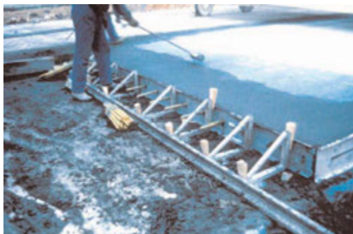
Figura 19. Encofrado en junta de final de día.
