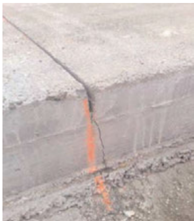
Figura 10. Aparición de fisura por debajo del corte de la sierra.
