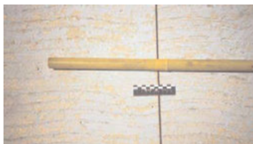
Figura 22. Disposición de pasadores previamente al hormigonado o insertados durante el mismo.
