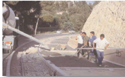
Figura 20. Pavimento con juntas formadas por elementos prefabricados.
