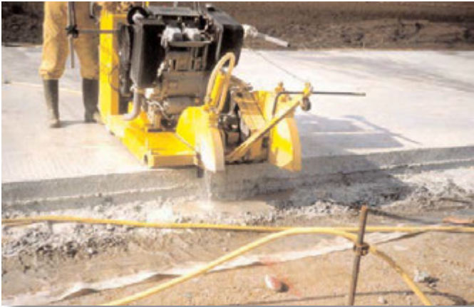
Figura 10. Aparición de fisura por debajo del corte de la sierra.
