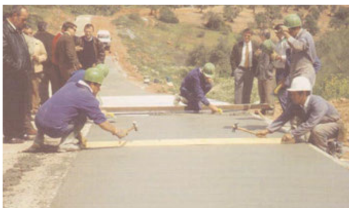
Figura 14. Introducción de elemento rígido en una junta formada en fresco.
