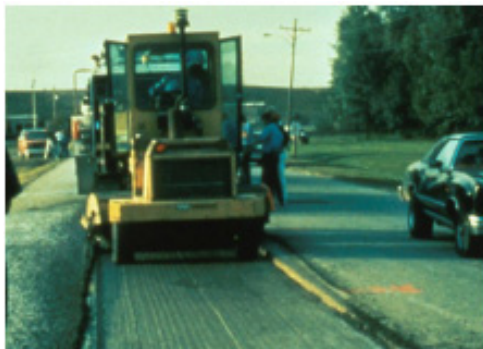
Fresado de mezcla bituminosa para mejorar la adherencia
