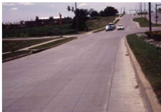
Juntas próximas en refuerzo ultradelgado adherido
