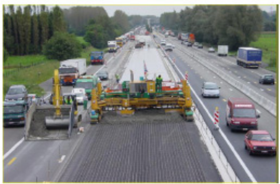
Refuerzo con pavimento continuo de hormigón armado
