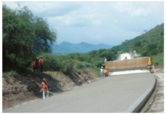
Ejecución con refuerzo no adherido
