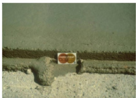
Refuerzo ultradelgado adherido a firme bituminoso
