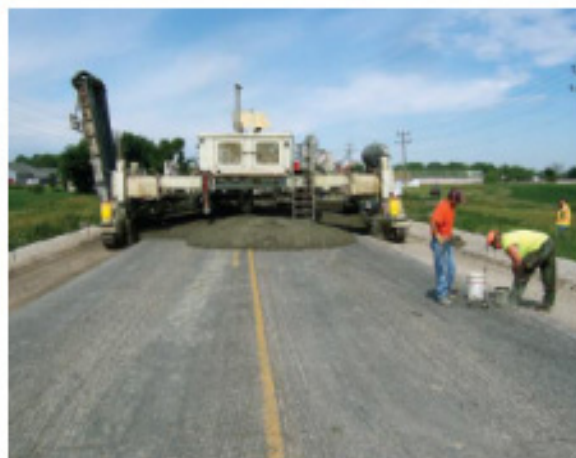
Extensión de hormigón sobre firme bituminoso fresado previamente para regularizar el espesor del refuerzo
