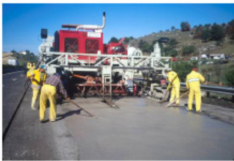
Extensión de un refuerzo de hormigón (inlay) en una caja abierta en el firme existente
