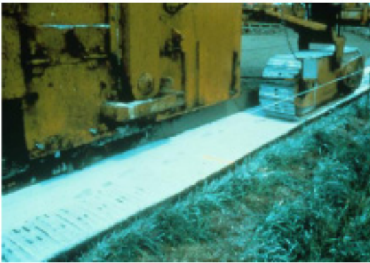
Riego previo con producto de color blanco para disminución de la temperatura de la mezcla bituminosa
