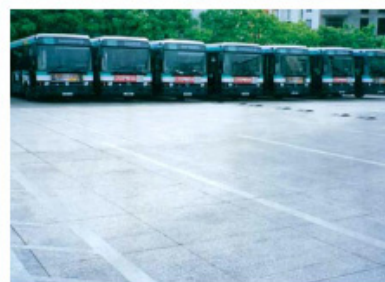
Refuerzo ultradelgado adherido en estacionamiento de autobuses
