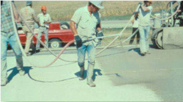
Extensión de lechada
